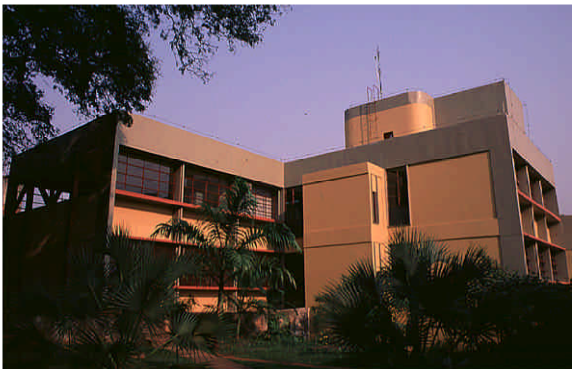
Prédio do Departamento de Ciências Florestais da ESALQ/USP, onde está localizada a Biblioteca do IPEF e alguns laboratórios que são utilizados nos projetos do Instituto.
