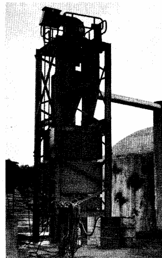
Recuperador de alcatrão em fornos de alvenaria
