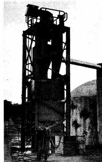
Recuperador de alcatrão em fornos de alvenaria
