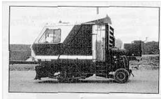
Figura 21. Unidade de controle aguardando conexão (Provencher, 1997).
