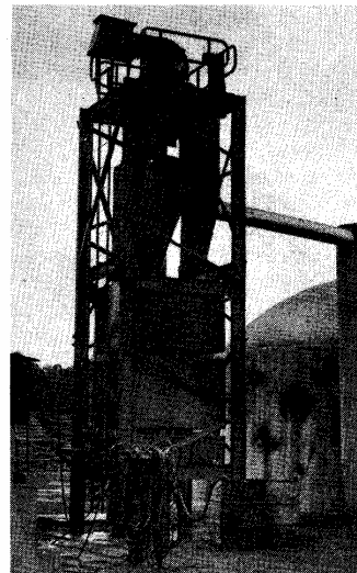
Recuperador de alcatrão em fornos de alvenaria
