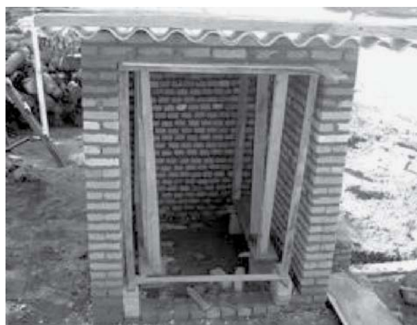
Figura 2. Detalhes da construção da unidade isolante.
